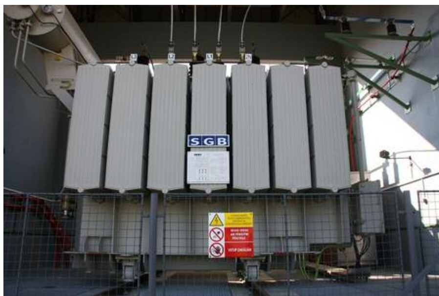
22) Olejový transformátor – Oil transformer (Foto: J. Kukla)
