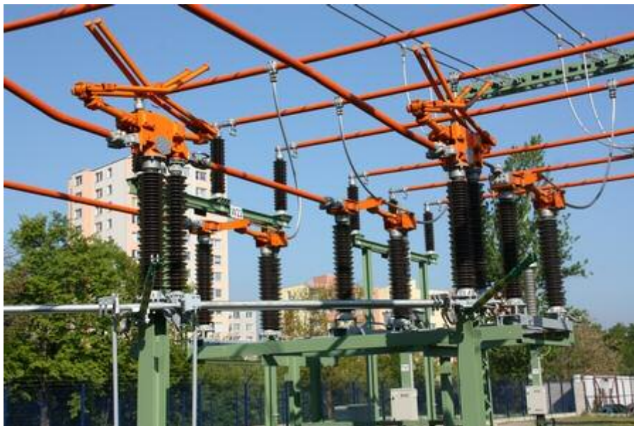
23) Odpojovače VVN – Disconnectors of high voltage (Foto: J. Kukla)
