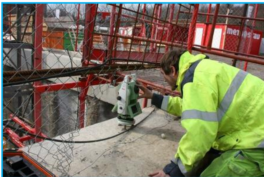
18) Zaměřování stavby – Surveying of a building (Foto: J. Kukla)
