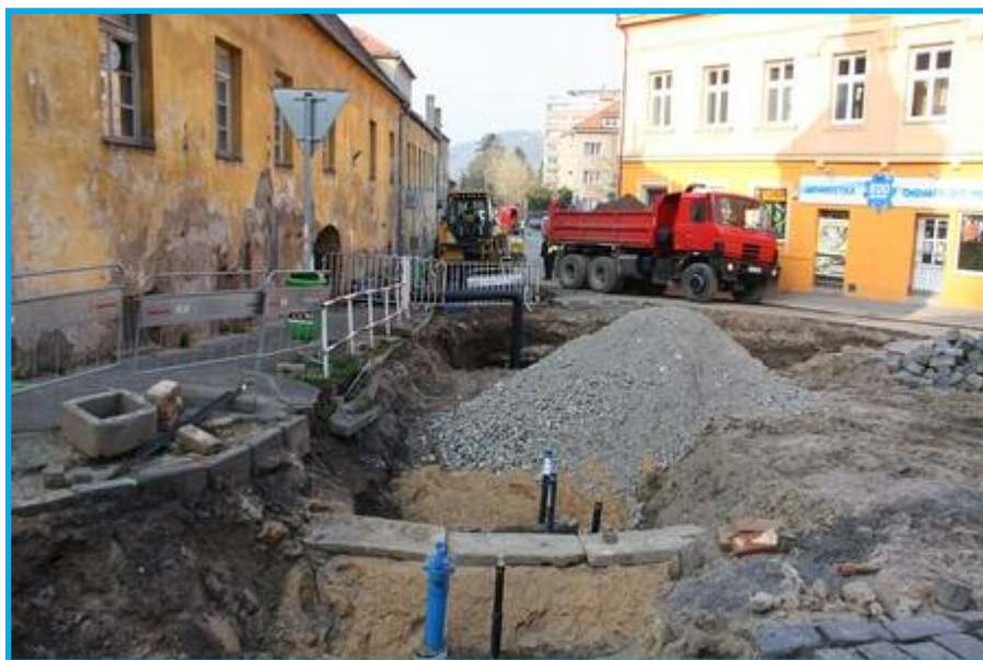
38) Oprava vodovodní přípojky – Water connection repairs (Foto: J. Kukla)
