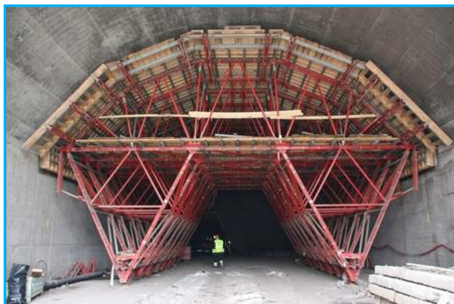
56) Konstrukce lešení – A scaffolding construction (Foto: J. Kukla)
