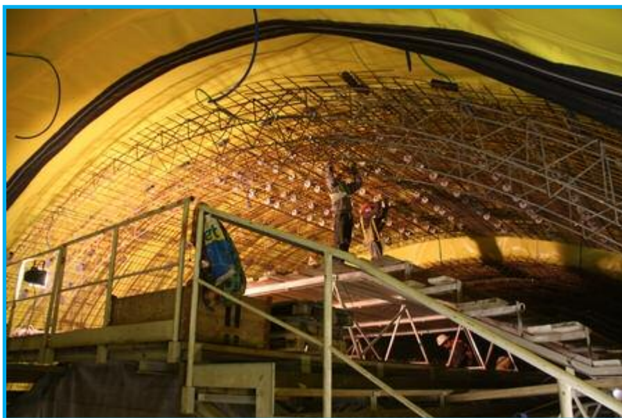
54) Betonování tunelu – Laying concrete in a tunnel (Foto: J. Kukla)
