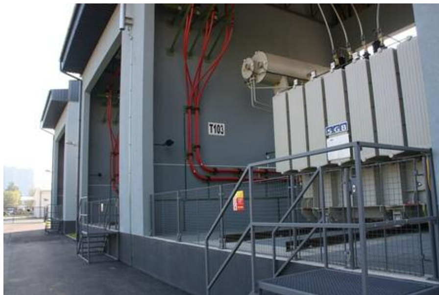
71) Olejový transformátor 110/22 kV – An oil transformer (Foto: J. Kukla)
