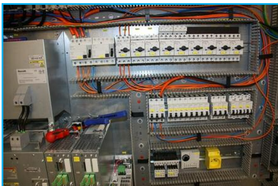
80) Elektrický rozvaděč – An electric switchboard (Foto: J. Kukla)
