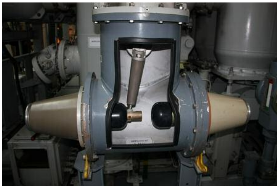
51) Řez vakuovým odpojovačem – A cut through a vacuum isolator (Foto: J. Kukla)
