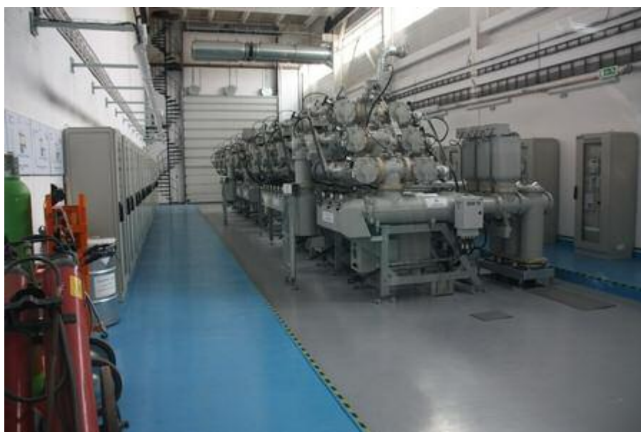
70) Vnitřní rozvodna 110/22 kV – An indoor substation 110/22 kV (Foto: J. Kukla)
