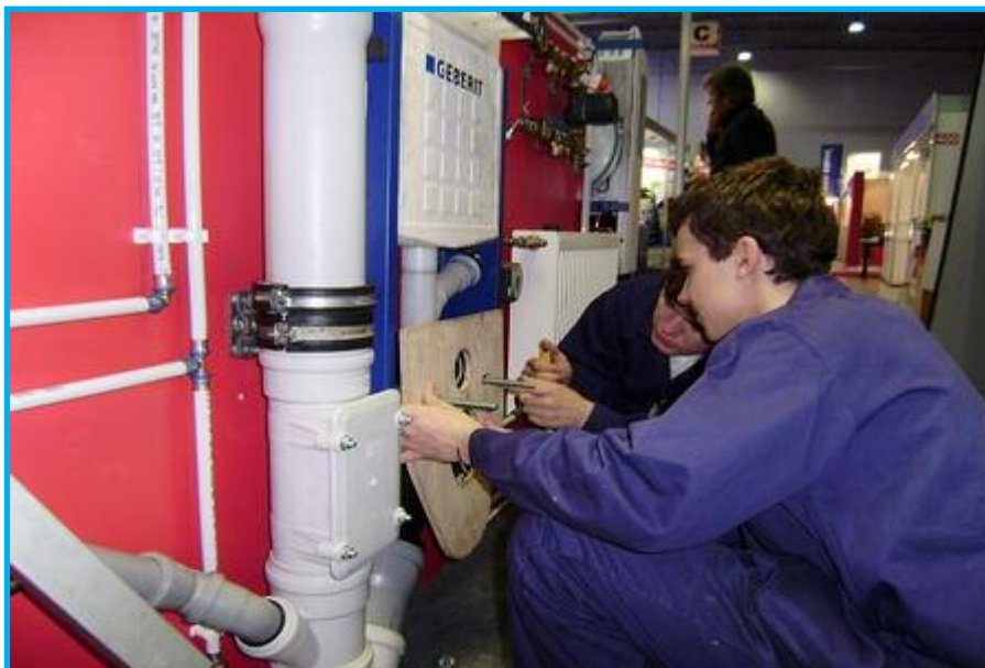
41) Instalace odpadních trubek – An installation of drain pipes (Foto: J. Kukla)
