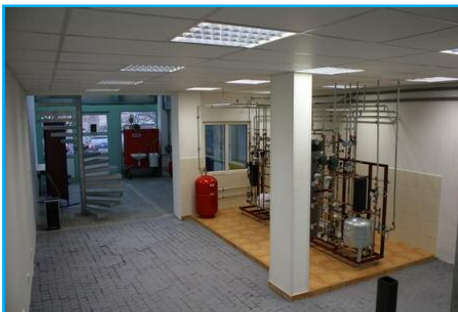
73) Centrální jednotka pro ohřev vody – A central unit for heating of water (Foto: J. Kukla)
