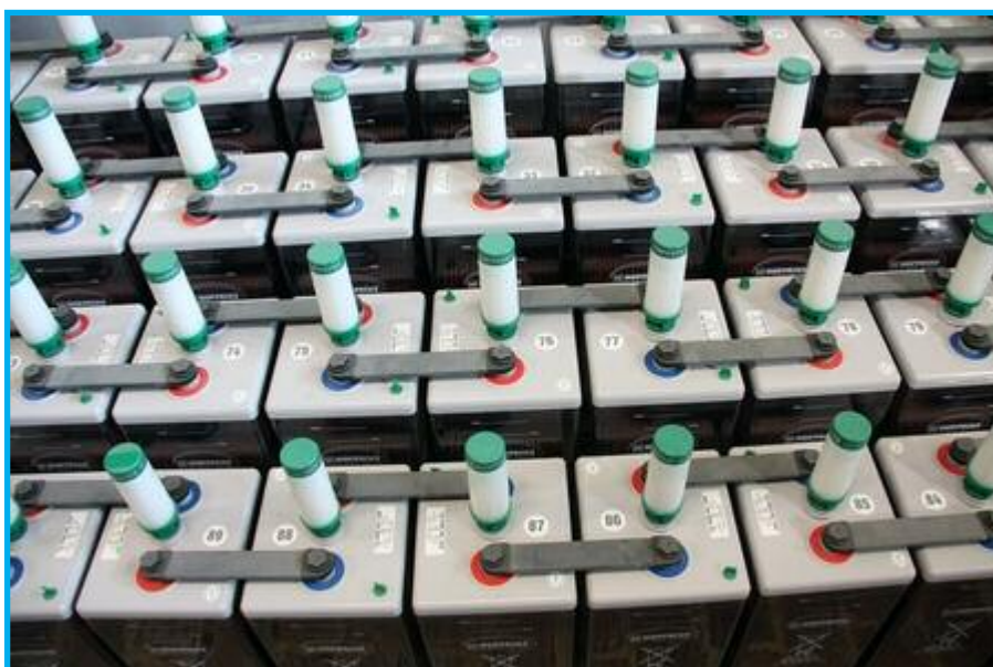
36) Olověné akumulátory – Lead-acid batteries (Foto: J. Kukla)
